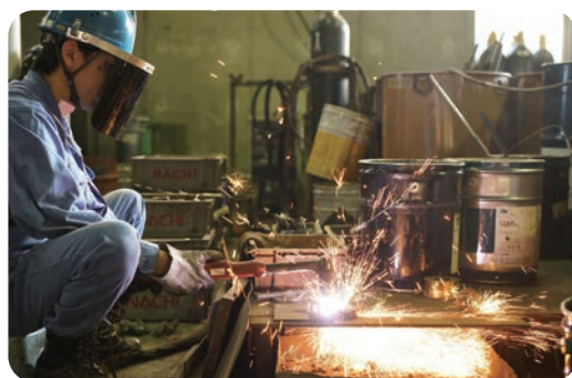
プラズマ切断
